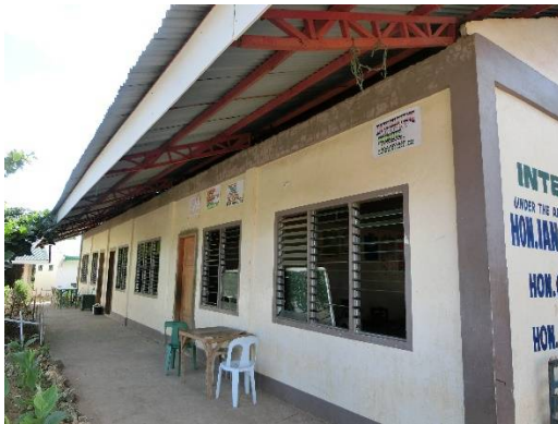
屋根と窓、ドアの修理
