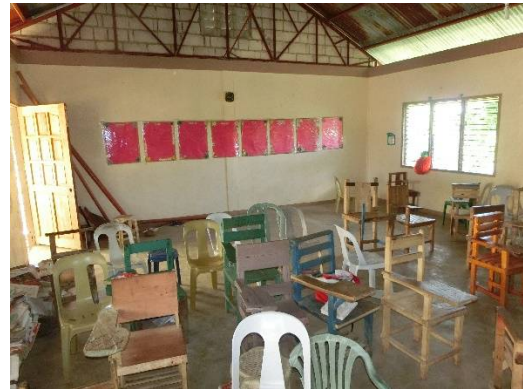
床のコンクリート整備
